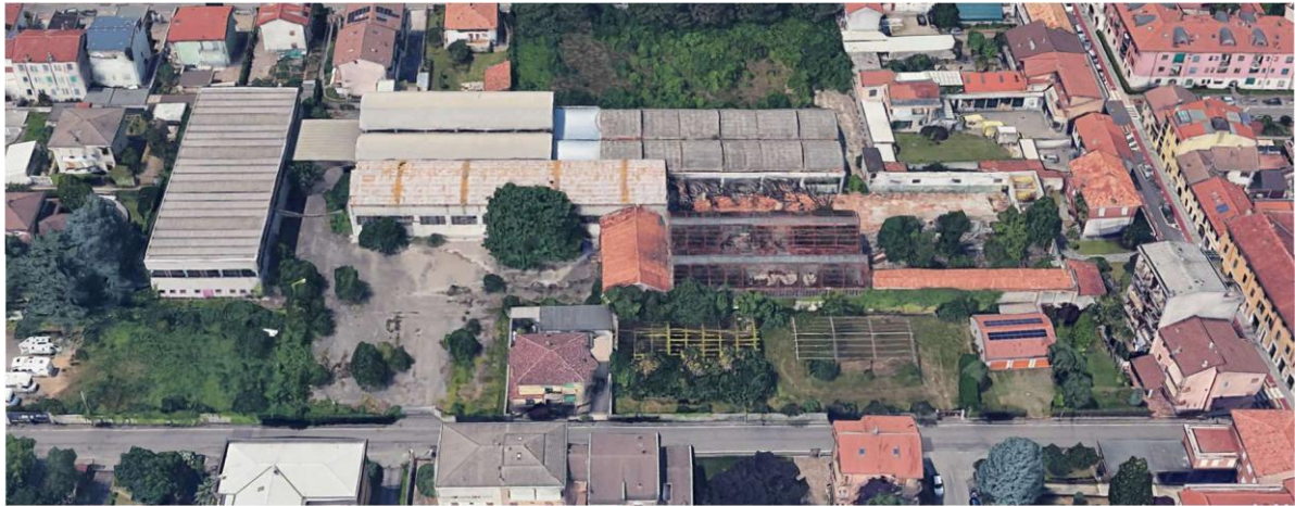
Figura 6 esempi di aree edifici dismessi sul territorio dell'Ambito. Fonte: Dastu Politecnico di Milano su Google Earth
